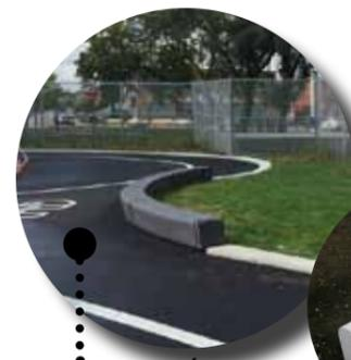
BORDURE-BANC DE BÉTON
